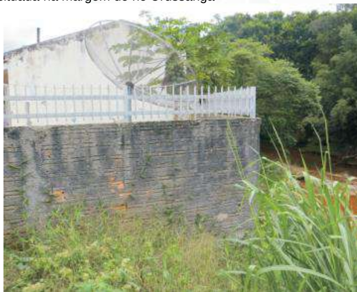
Figura 12: Moradia situada na margem do rio Urussanga
