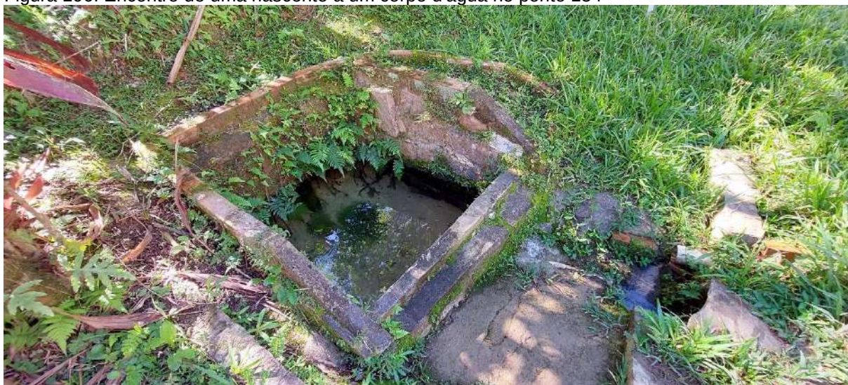
Figura 106: Encontro de uma nascente a um corpo d'água no ponto 154
