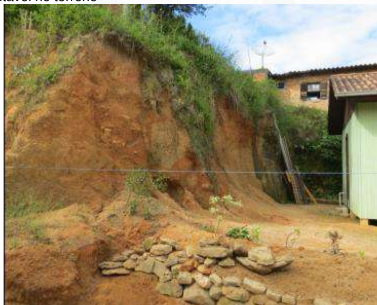
Figura 23: Corte instável no terreno
