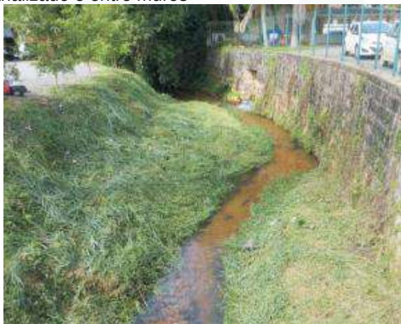
Figura 10: Rio América canalizado e entre muros
