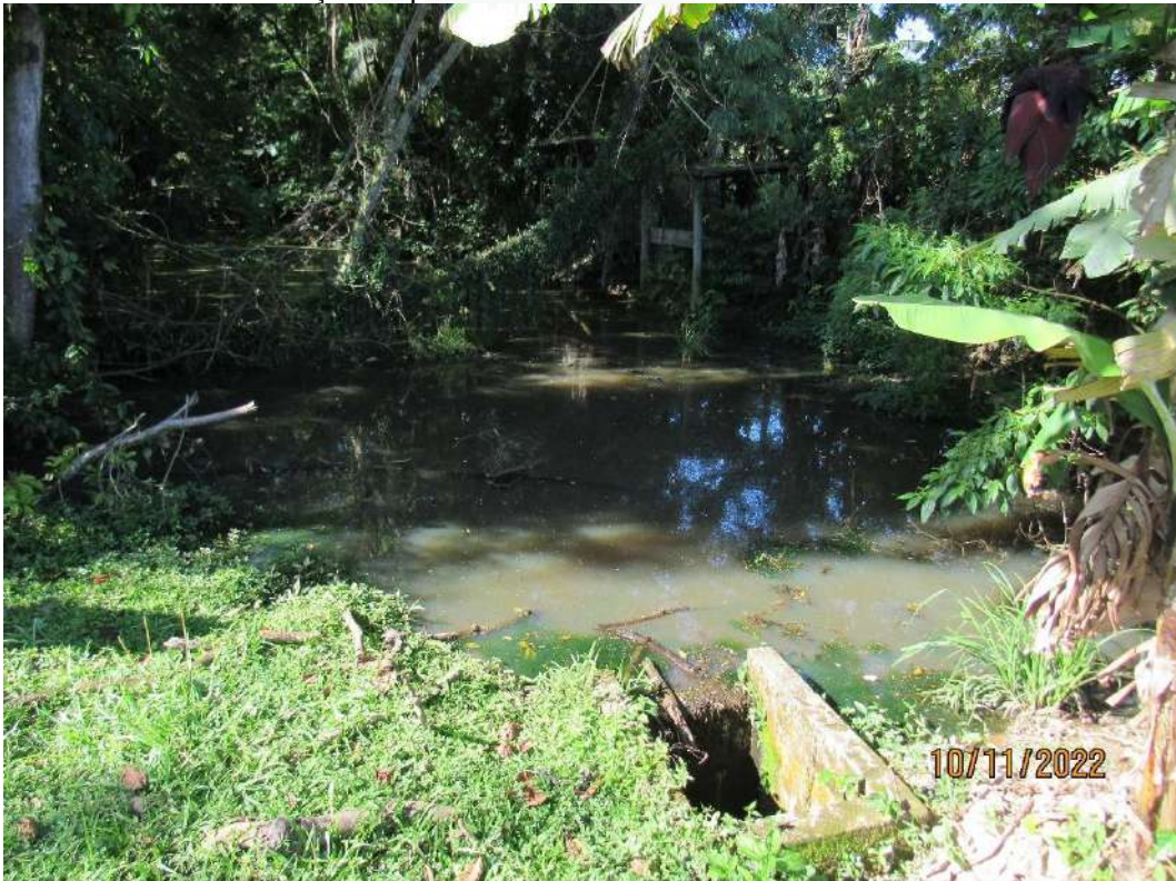
Figura 153: Entrada na tubulação no ponto 132
