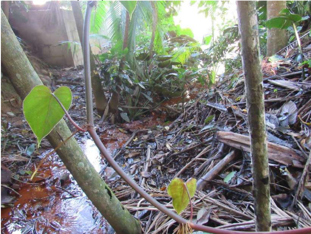
Figura 115: Saída de tubulação no ponto 58
