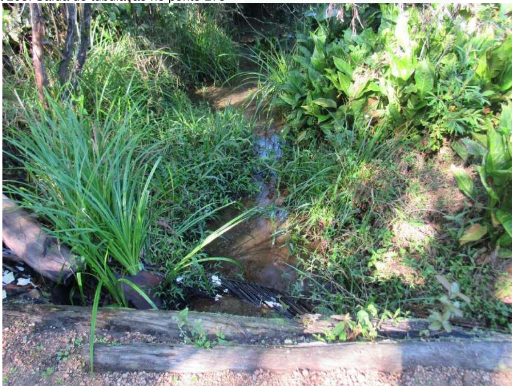
Figura 205: Saída de tubulação no ponto 175
