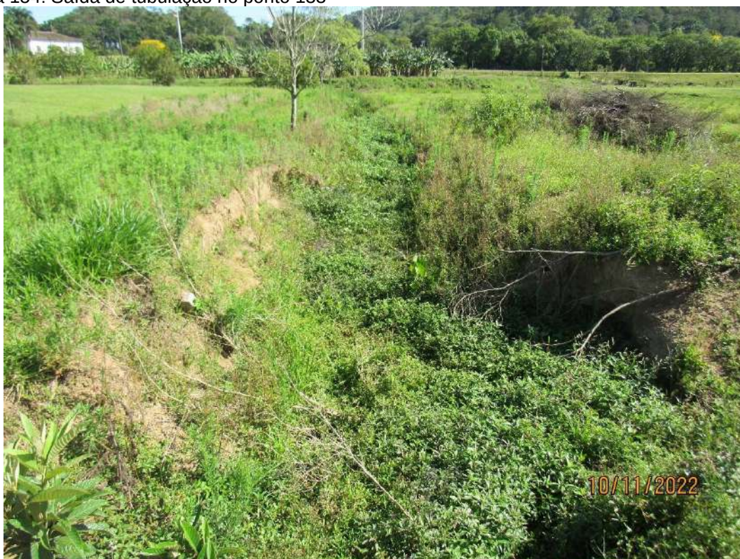
Figura 154: Saída de tubulação no ponto 133
