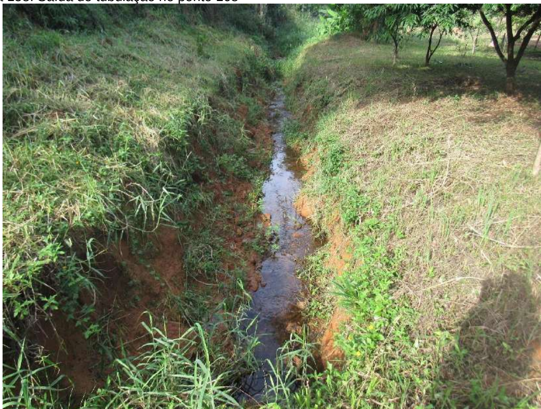
Figura 158: Saída de tubulação no ponto 168
