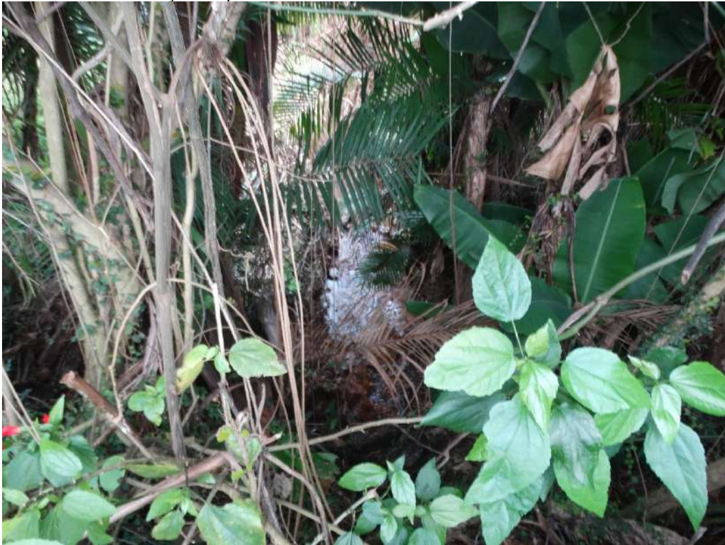
Figura 67: Saída de tubulação no ponto 63
