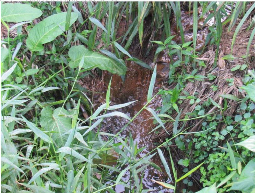
Figura 126: Entrada de tubulação no ponto 188
