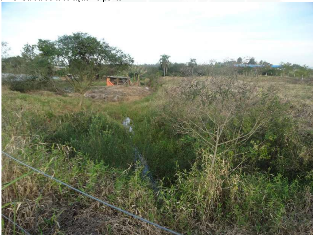
Figura 218: Saída de tubulação no ponto 117
