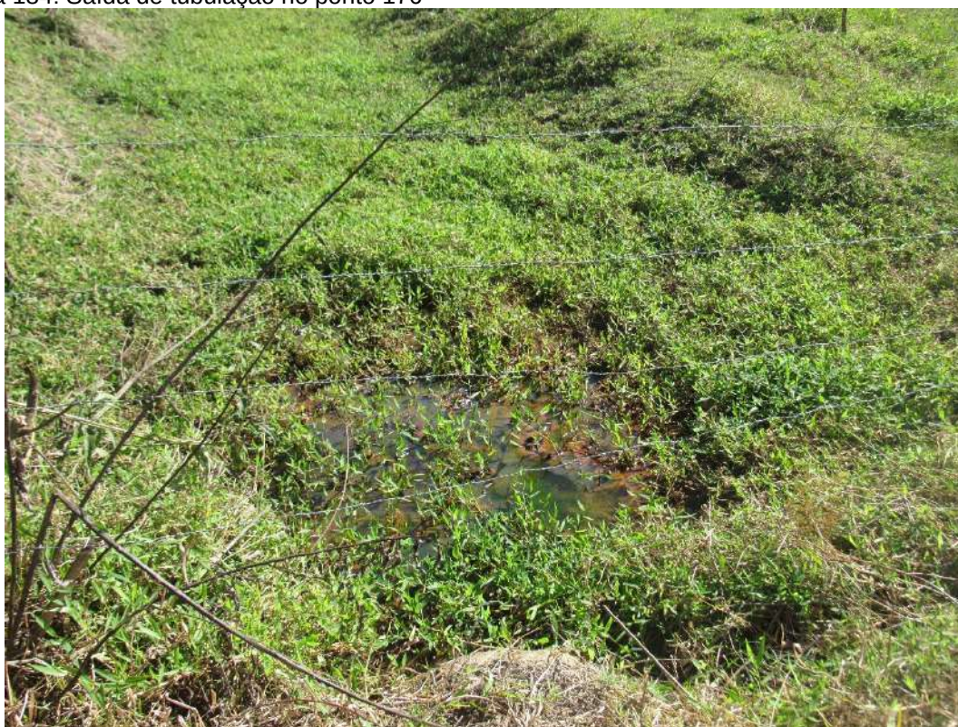
Figura 184: Saída de tubulação no ponto 176
