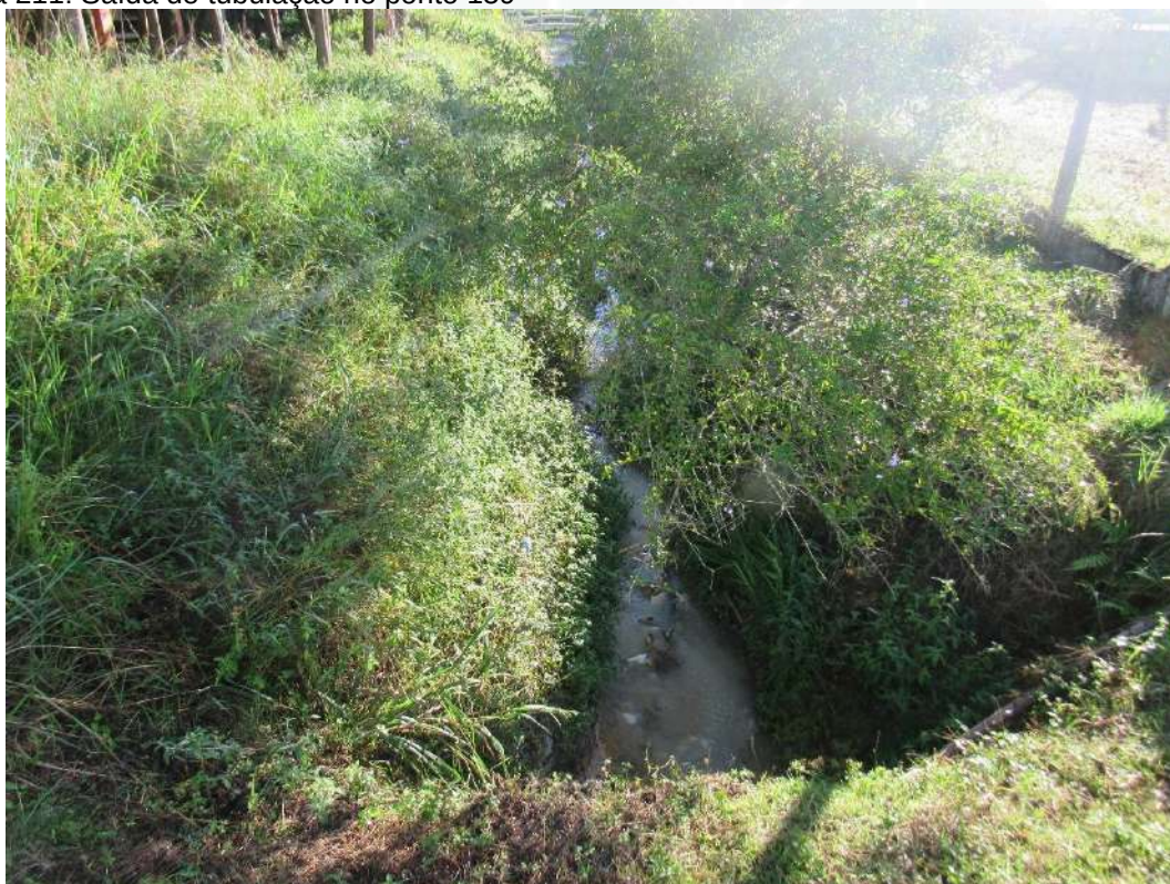
Figura 211: Saída de tubulação no ponto 159
