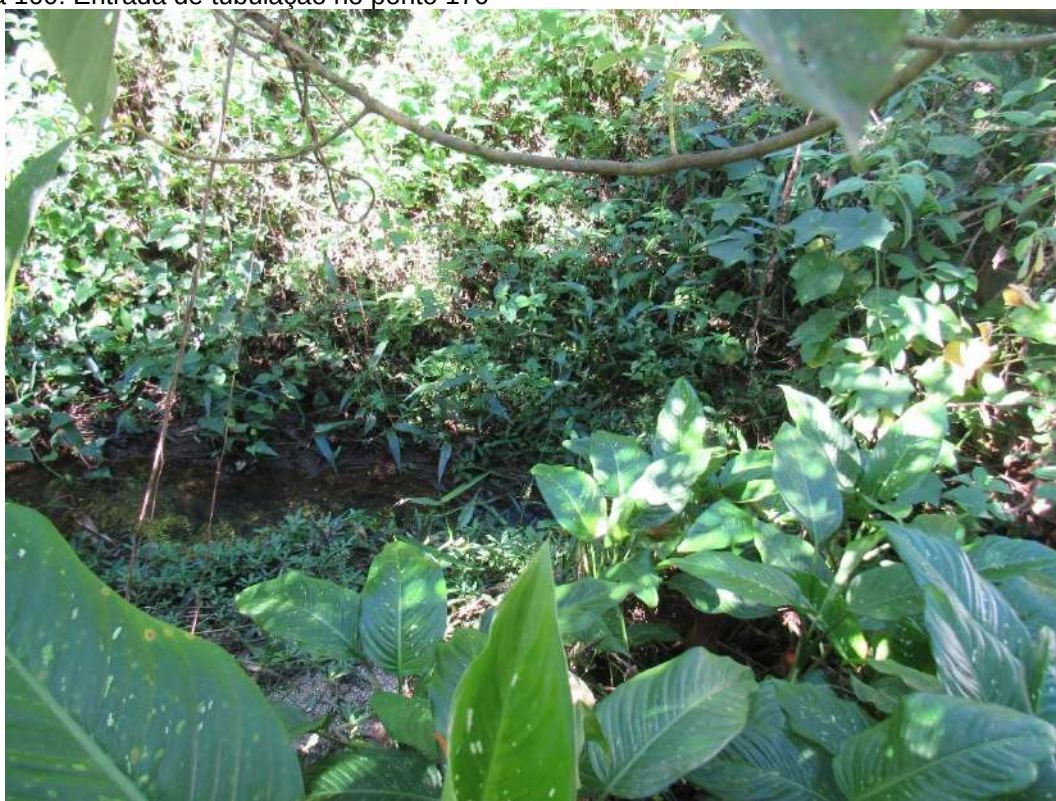
Figura 160: Entrada de tubulação no ponto 170
