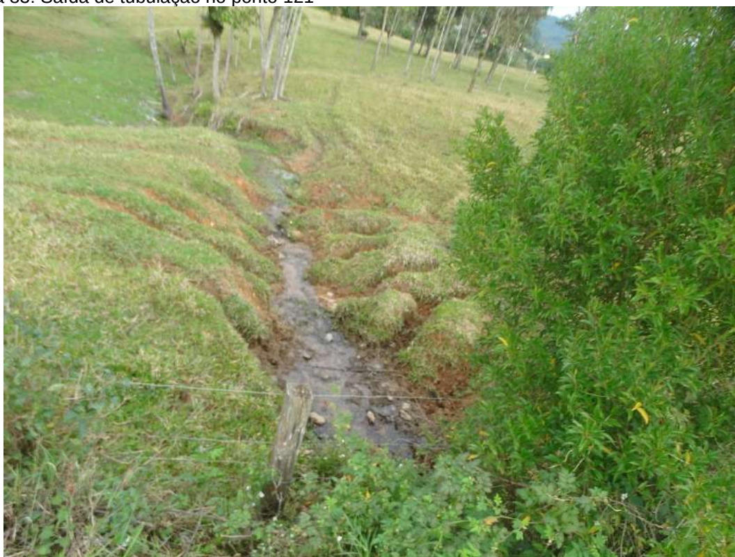
Figura 83: Saída de tubulação no ponto 121
