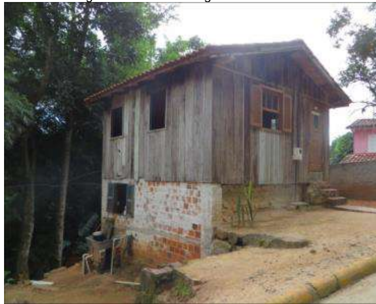
Figura 8: Moradia situada na margem do rio Urussanga
