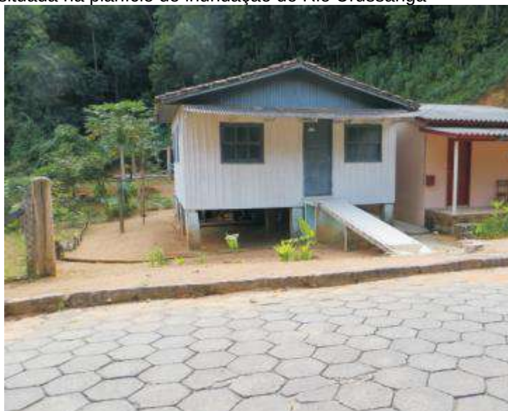
Figura 19: Moradia situada na planície de inundação do Rio Urussanga
