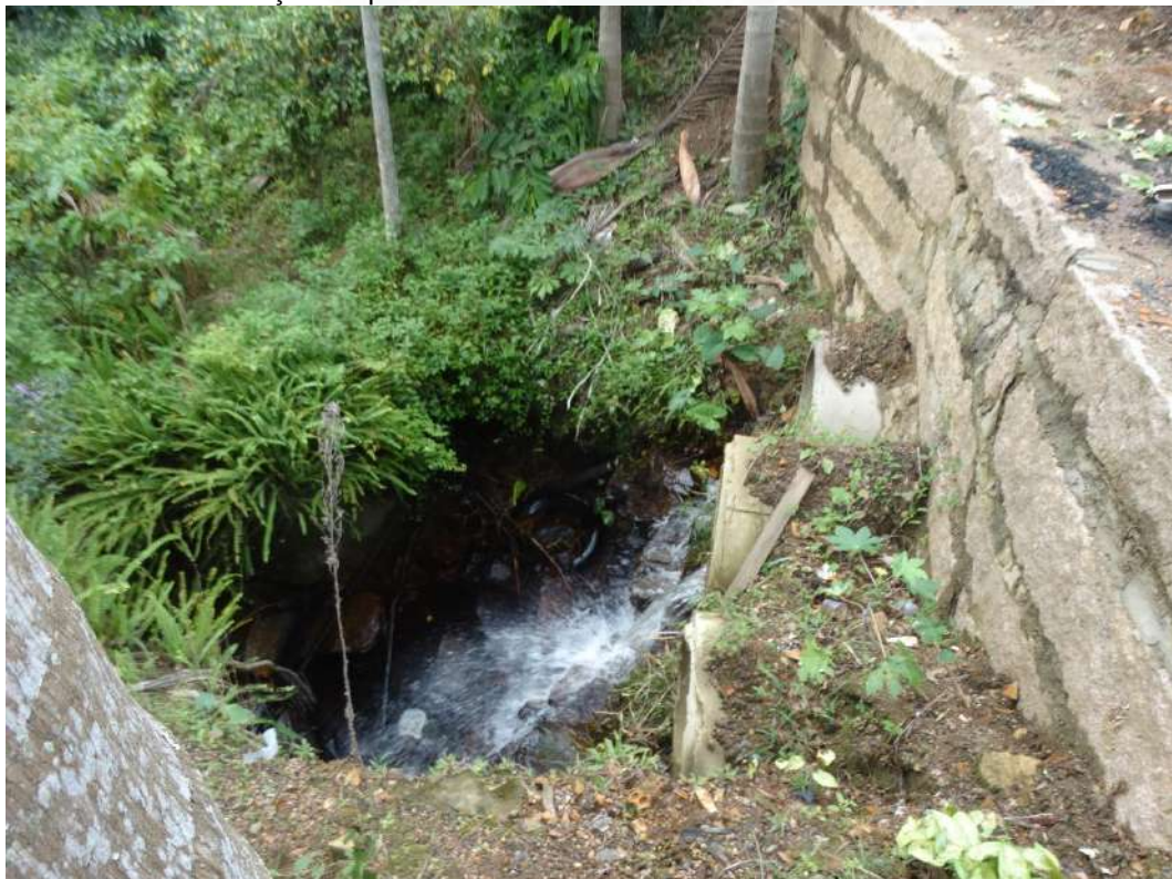
Figura 66: Saída de tubulação no ponto 61
