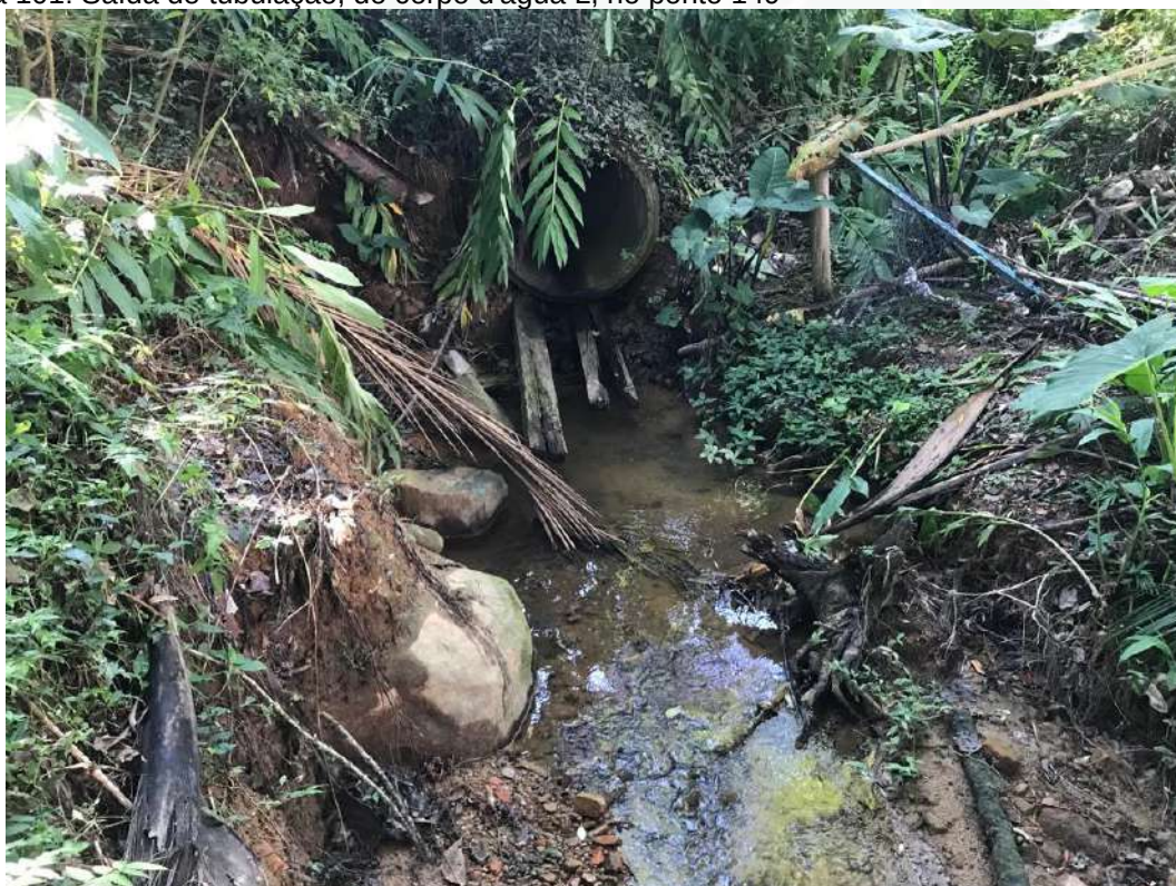
Figura 101: Saída de tubulação, do corpo d'água L, no ponto 149
