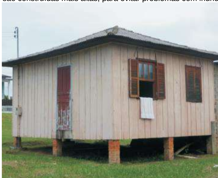
Figura 17: As casas são construídas mais altas, para evitar problemas com inundações
