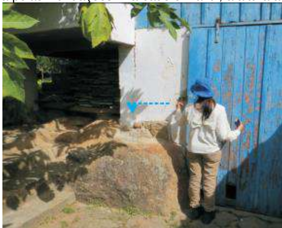
Figura 11: Moradia atingida pelas inundações. Marcado em azul, a altura alcançada pela água
