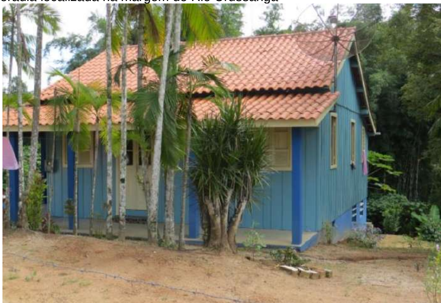
Figura 20: Moradia localizada na margem do Rio Urussanga
