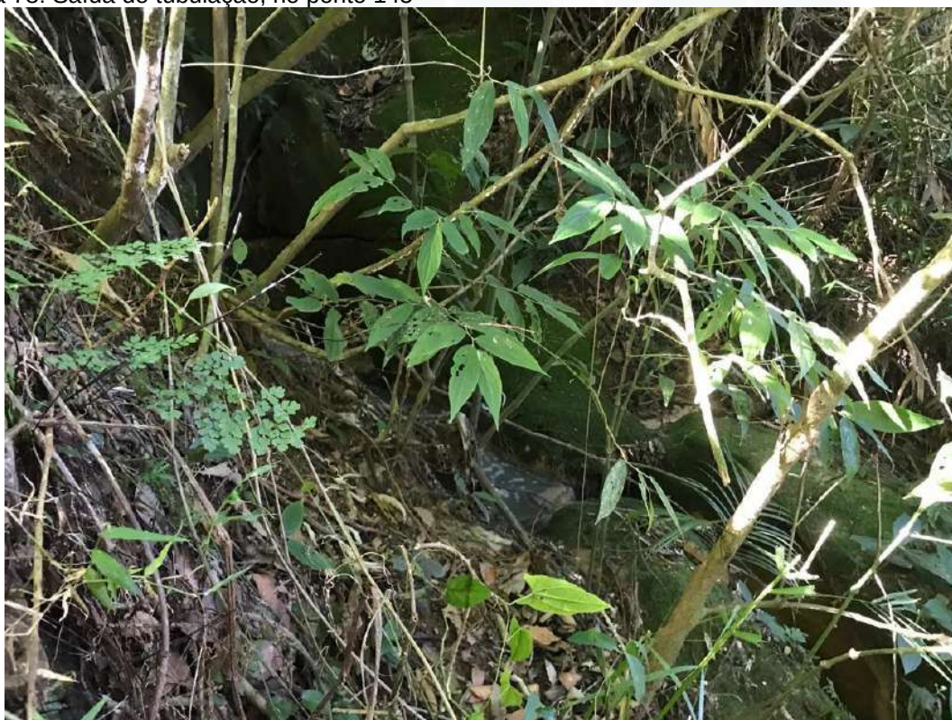
Figura 78: Saída de tubulação, no ponto 145
