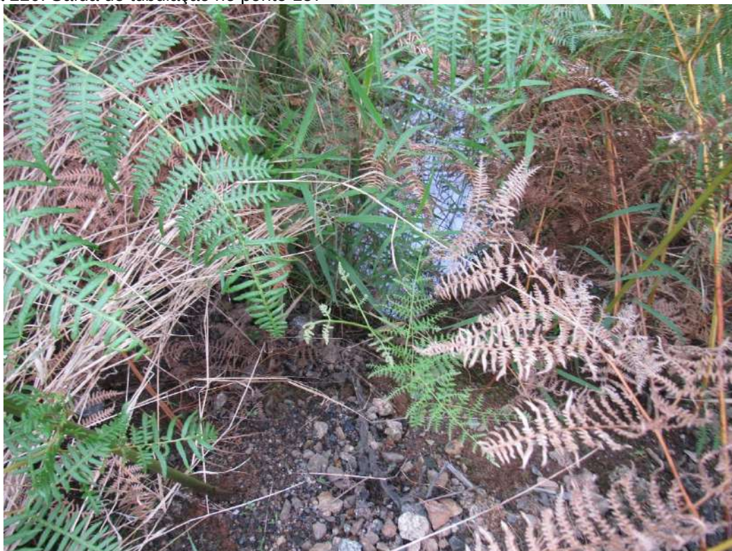
Figura 220: Saída de tubulação no ponto 157
