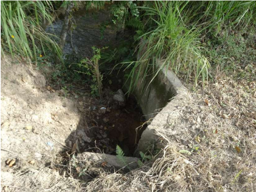
Figura 119: Saída de tubulação do corpo d'água J no ponto 103
