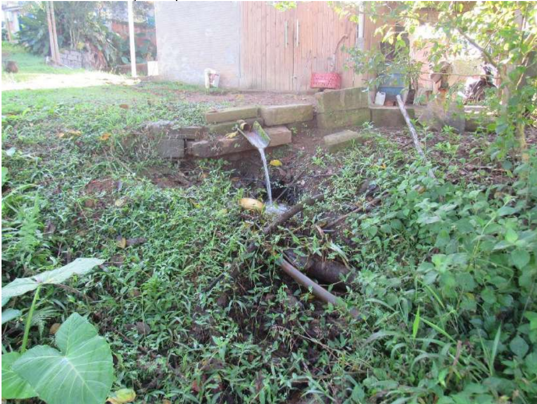
Figura 127: Saída de tubulação no ponto 189
