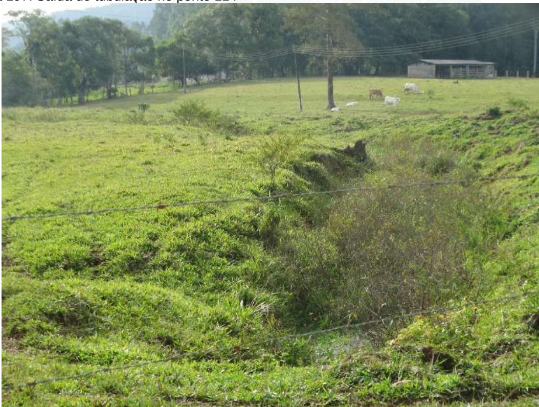
Figura 197: Saída de tubulação no ponto 114
